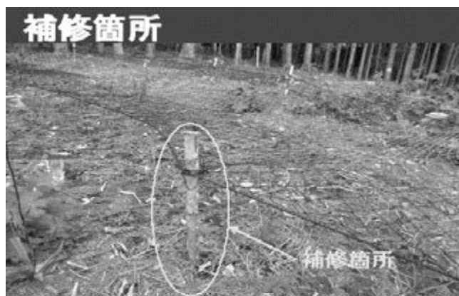
写真-10 支柱補修後
