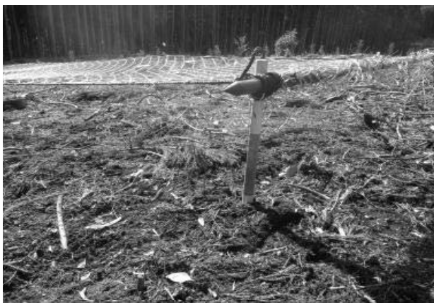
写真-3 支柱の設置状況
