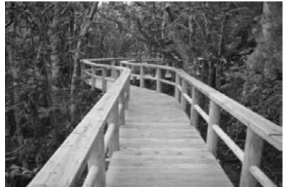
写真-1 完成した木道
