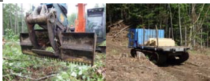
一貫作業で活躍した大型機械 グラブ+レーキとフォワーダ
