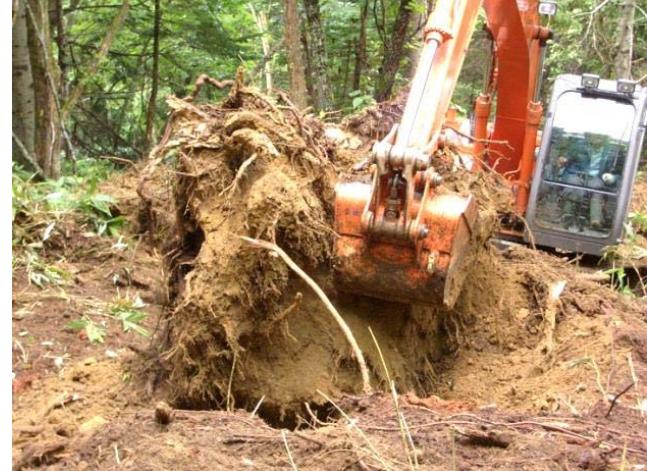
図6 根返し箇所の施工風景
