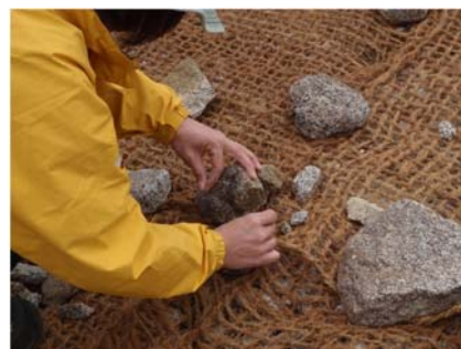
マット補修箇所への播種 (風で飛ばないように石の下へ播種)
