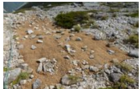
植生マット敷設後
