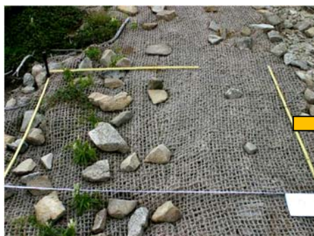
マット敷設直後 (天狗荘北西：平成18年)
