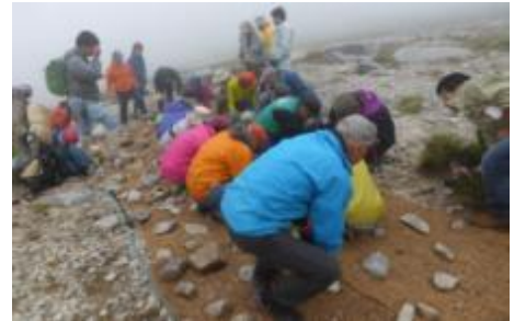
植生マット敷設作業
