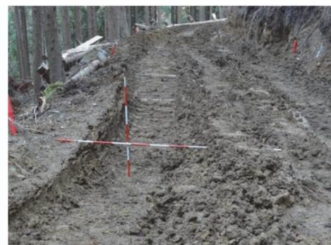
図-4 路面の横断形状
