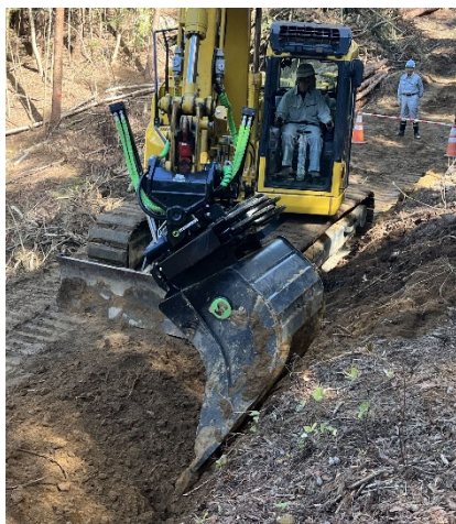
<写真1：現場でのチルトローテータ活用>
