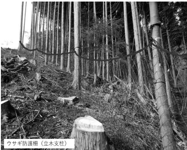
写真－6 立木を使用した柵の設置
