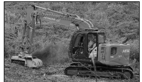
写真6：クラッシャー作業状況
