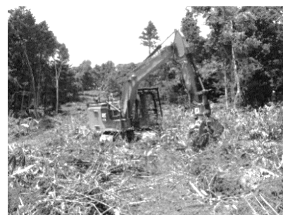
写真1 表土戻し作業中
