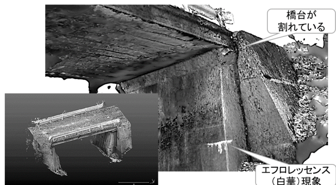
写真-6 三次元点群による施設点検
