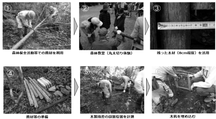
(写真4 木製段差の作設工程3-1)
