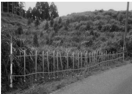
(写真4：竹によるネット補修現場)
