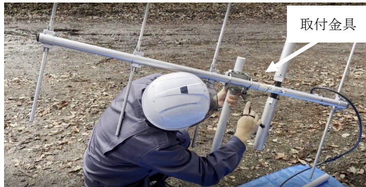
図 22 アンテナとポール接合作業
