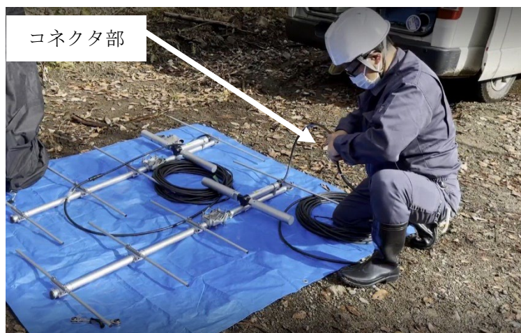
図 21 アンテナと同軸ケーブル接続作業
