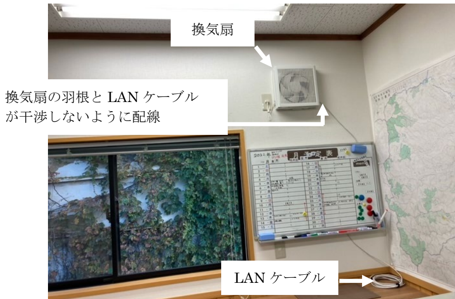
図 18 森林事務所の屋内への LAN ケーブル引き込み結果の外観
