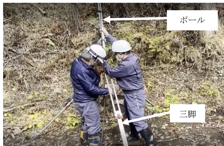
図 23 ポール・アンテナと三脚の組み立て作業
