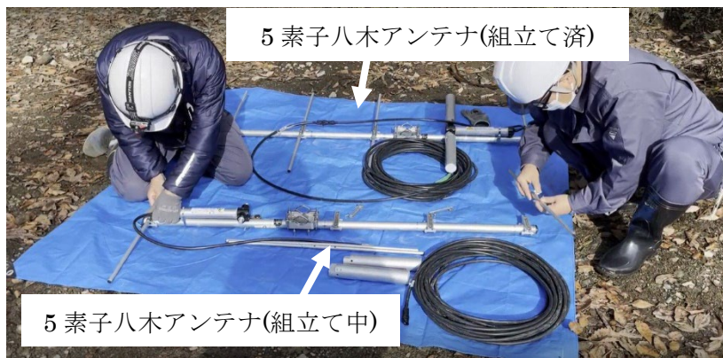
図 20 アンテナ組立作業
