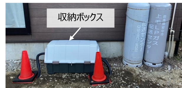
[3] 無線機器収納ケース(屋外設置) (盗難防止のため、施錠されていることを確認)
