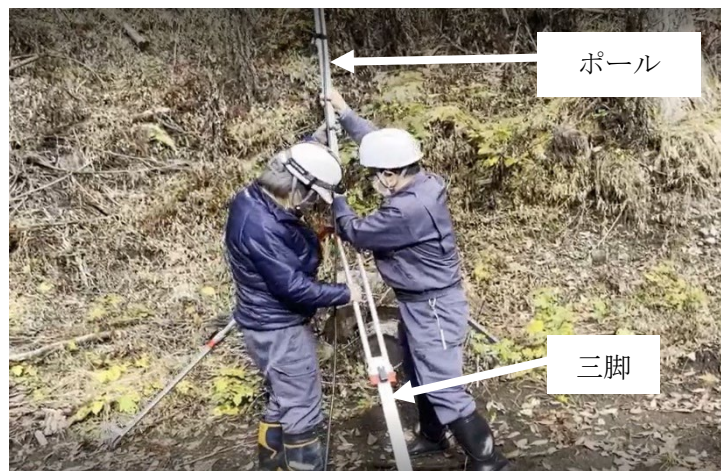
図 2.25 ポール・アンテナと三脚の組み立て作業
