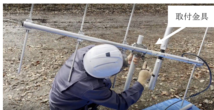
図 2.24 アンテナとポール接合作業
