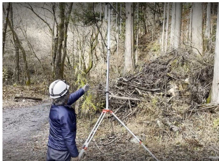
図 2.26 アンテナ位置 (方位) 決定作業
