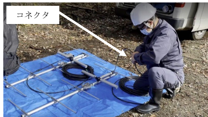
図 2.23 アンテナと同軸ケーブル接続作業
