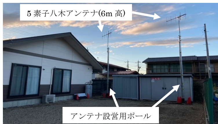
図 2.18 基地局側のアンテナ設置後の外観
