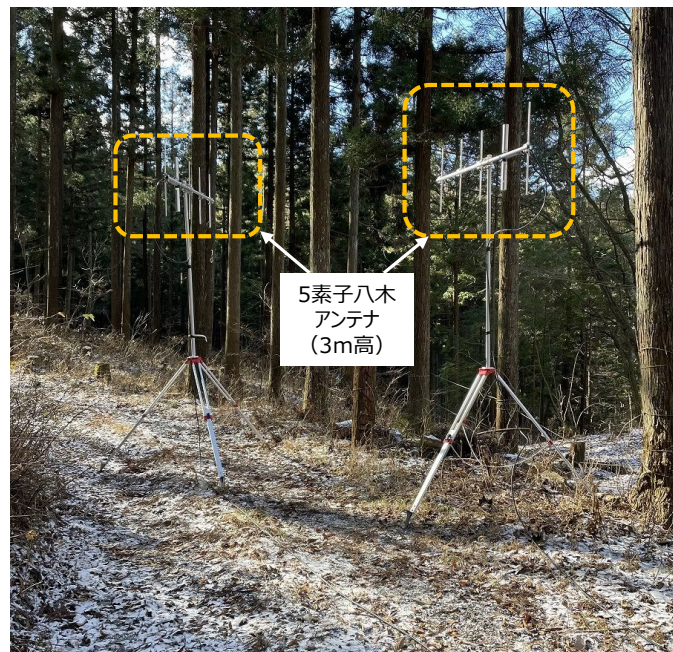
図 2.8 終端局（移動局）のアンテナ設備 (5 素子八木アンテナ、受信ダイバーシチ構成)
