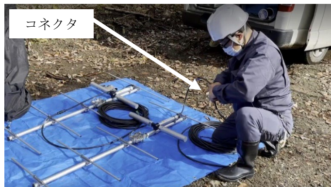
図 2.23 アンテナと同軸ケーブル接続作業
