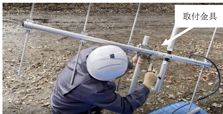
図 2.24 アンテナとポール接合作業
