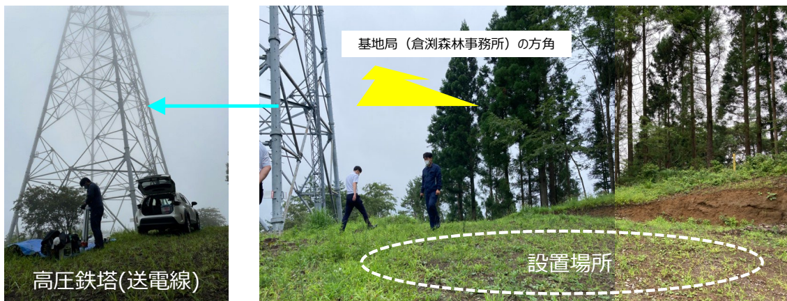
図 2.14 中継地点（大日影支線終点）の無線設備設置場所（事前現地調査）
