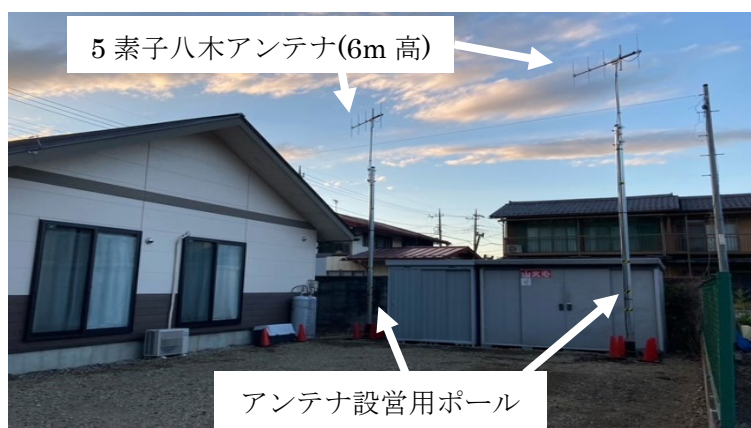
図 2.18 基地局側のアンテナ設置後の外観
