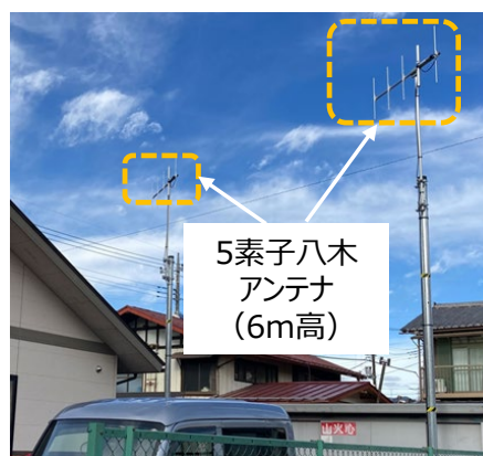
(a)5 素子八木アンテナ（受信ダイバーシチ構成（*1））
