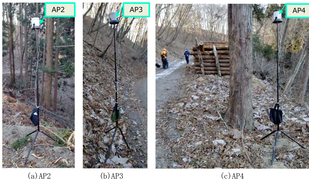
図 2.31 アクセス回線（メッシュ Wi-Fi AP2～AP4）の設置状況（作業現場）
