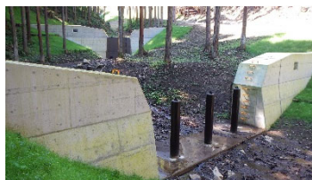
流木捕捉式治山ダムの設置
