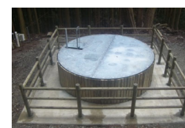
地すべり防止工（集水井・排水トンネル）
