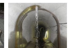
地すべり防止工（集水井・排水トンネル）
