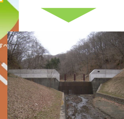
機能強化・老朽化対策（高上げ・流木止施設の付加）
