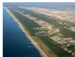
海岸防災林造成
