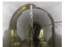
地すべり防止工（集水井・排水トンネル）
