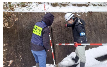
激甚災害後の治山施設の点検支援
