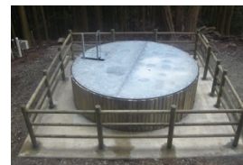
地すべり防止工（集水井・排水トンネル）
