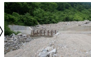
治山ダムに異常堆積した土石・流木の除去
