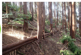
保安林整備（筋工・本数調整伐）
