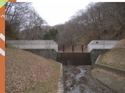
機能強化・老朽化対策 (嵩上げ・流木止施設の付加)
