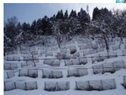
なだれ防止施設
