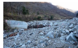
治山ダムに異常堆積した土石・流木の除去
