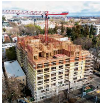
写真 2 : 建設中の様子
