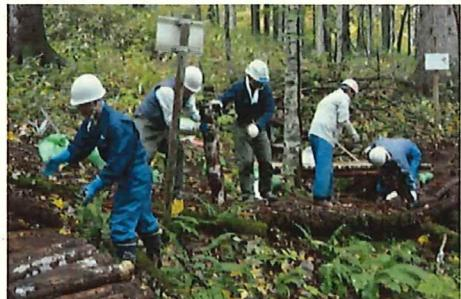
ふれセン職員から概要説明を受け、整地・土台丸太設置・横板の打込み、安定させるための土嚢積み、古い木橋の撤去で完成しました。
