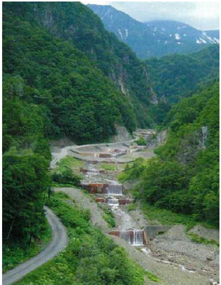
低ダム群により安定した溪床(層雲峡黒岳沢)
