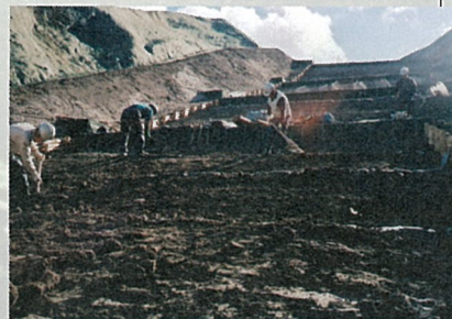
同左工事ガリー浸食防止対策工施工状況 (2006年9月撮影)
