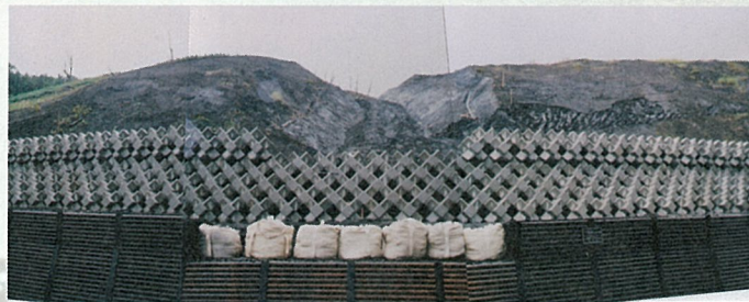
金比羅山火口周辺の治山対策工施工状況 コンクリートブロック治山ダム(2006年10月撮影)
