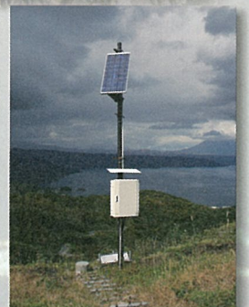
小有珠川源頭部に設置された伸縮計
