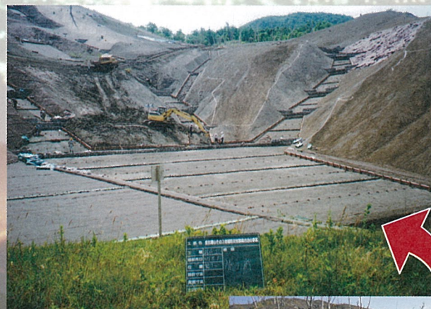
金比羅山中腹の山腹工 施工状況(2007年8月撮影)
