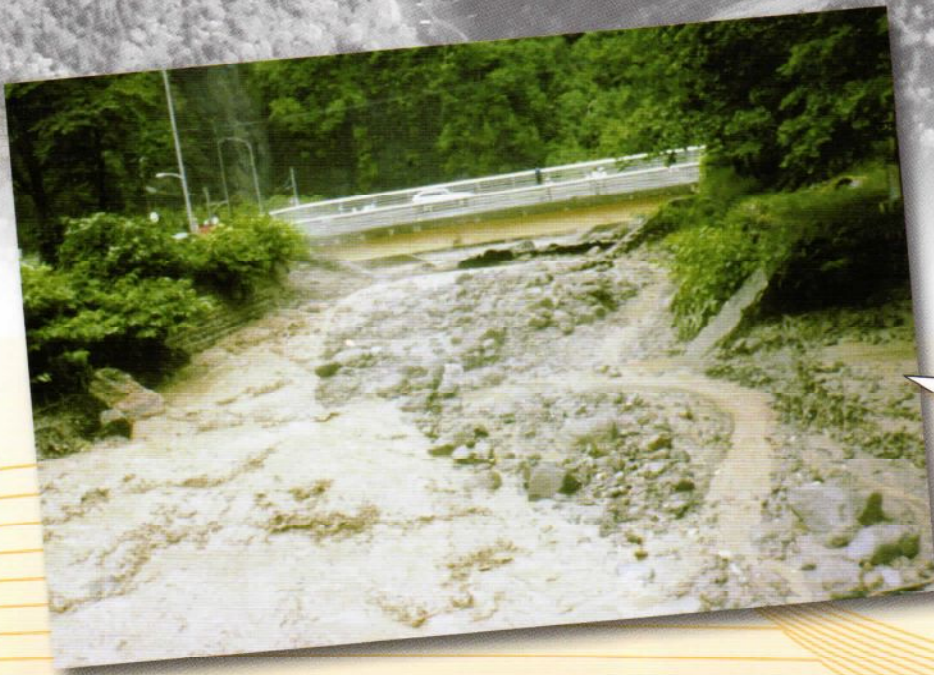
1981(昭和56)年8月豪雨により下流の流路工が閉塞。橋げたまで土砂が堆積した。 (写真提供:北海道開発局)
