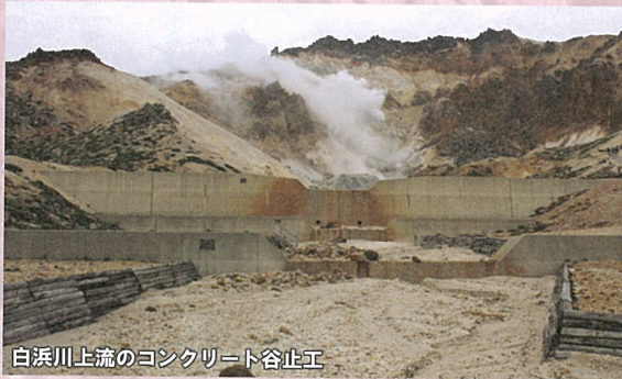
乱塔の沢：コンクリート谷止工
