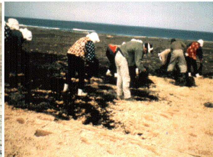
“えりも式緑化工法” 草を根付かせるため雑海藻をしきつめる 住民と試行錯誤の末開発したもの
