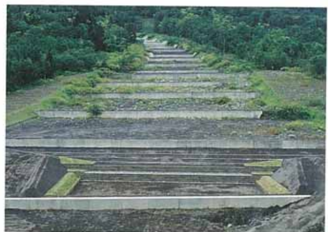
写真5-7 羊蹄山青木の沢 浸透工法 (H6)
