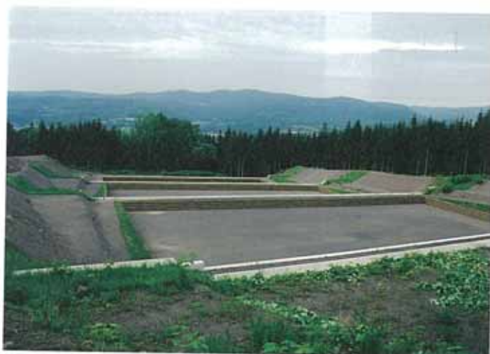
写真5-9 学校の沢浸透池(H17.7)
