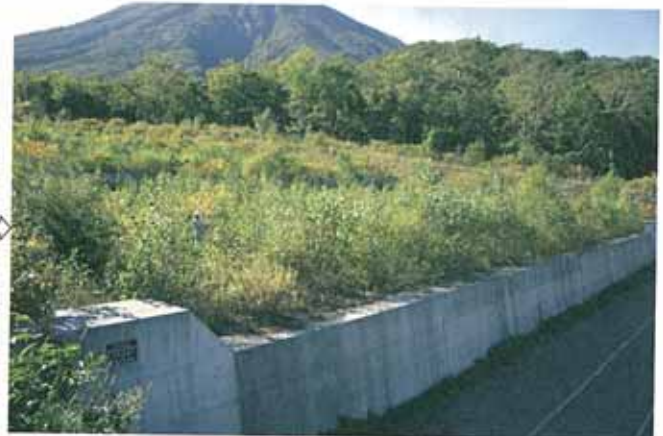
同左地点付近H7. No40号拡散工の現況（2006.9）
