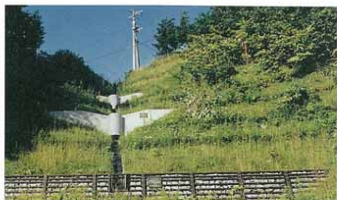
1991年 同左山腹工事後の復旧状況
