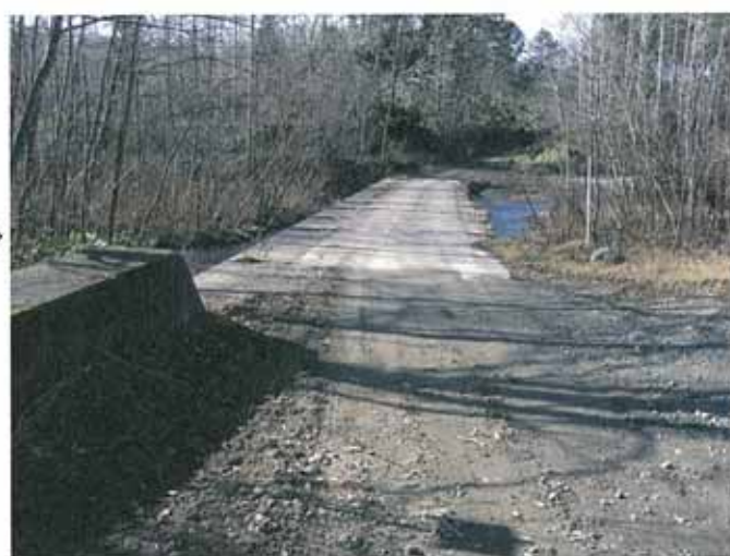
同左ダム周辺の現況(2004)
