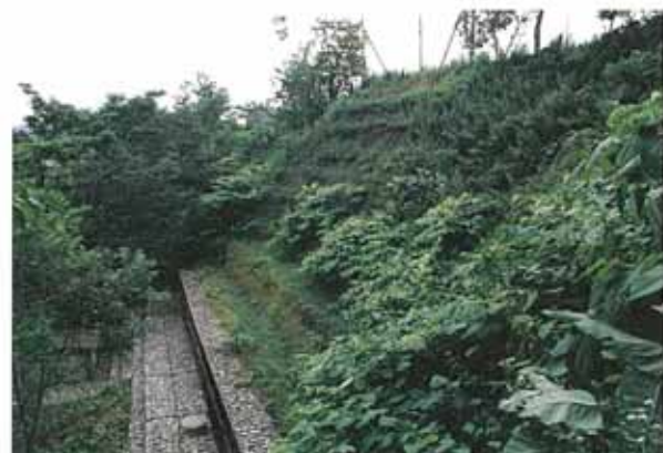
1991年 同左山腹工事後の復旧状況
