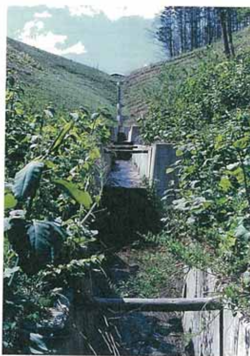
写真5-14 工事後の復旧状況（巽地区：S62.6）
