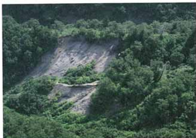
写真5-11 学校の沢 航空実播施工前全景(1997. 8)
