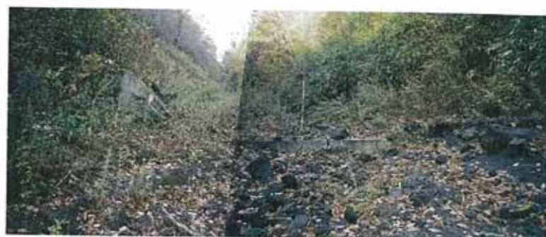
同上地点 S57. No20号埋没状況（2001. 9）
