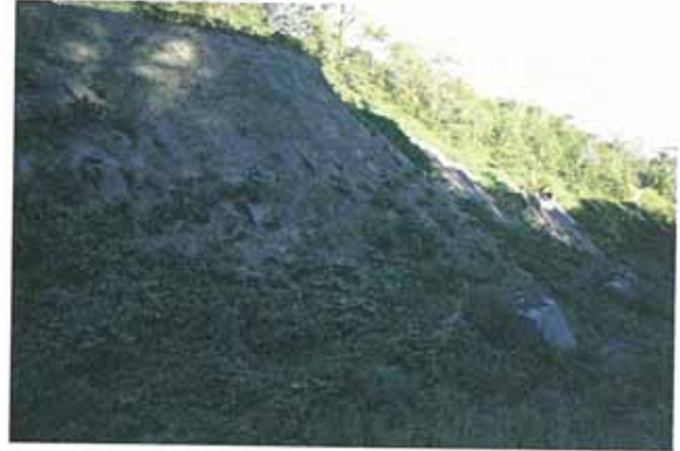
標高640m付近左岸山腹施工地（2006.9）
