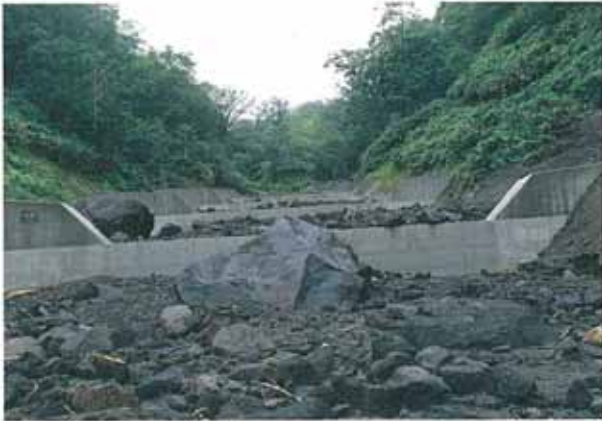
中流域標高550m付近S58ダム埋没状況（1986.9）
