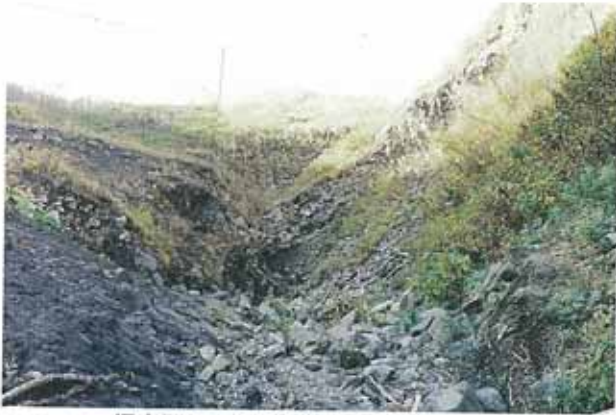
標高750m付近施工困難地（2006.10）
