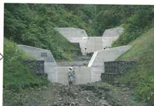
同左地点H16. No74号の現況（2006. 9）
