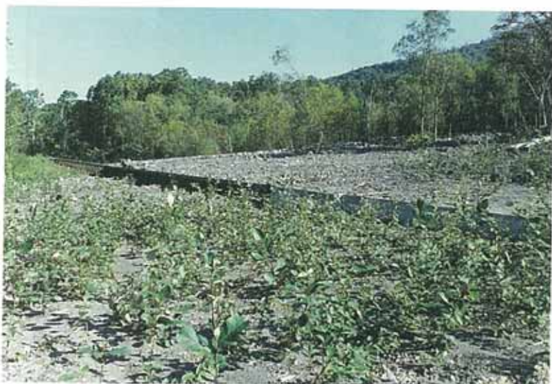
写真6-3 青木の沢低ダム群最下流 ドロノキ埋枝工(1978)
