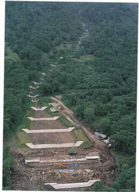
写真5-4 低ダム群の施工状況（H7：滝の沢下流）
