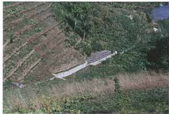
1984年 同左復旧状況 (下方を望む)
