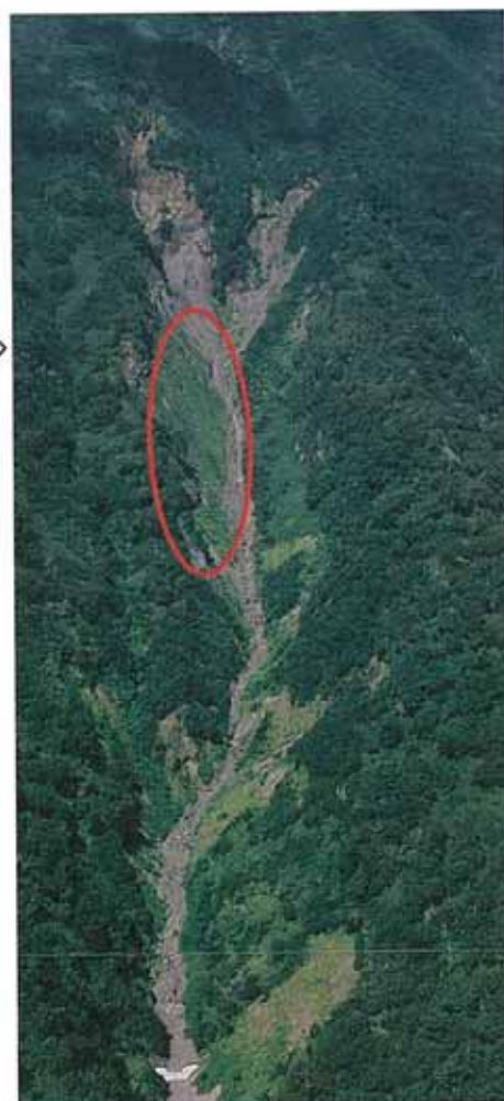
滝の沢 航空実播施工後全景(2000. 8)
