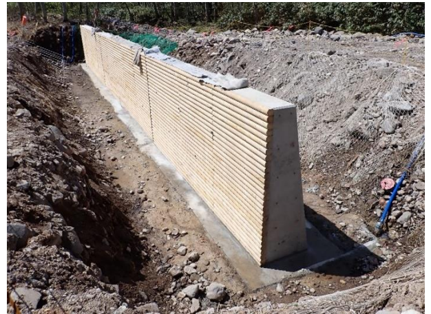
木製残存型枠
