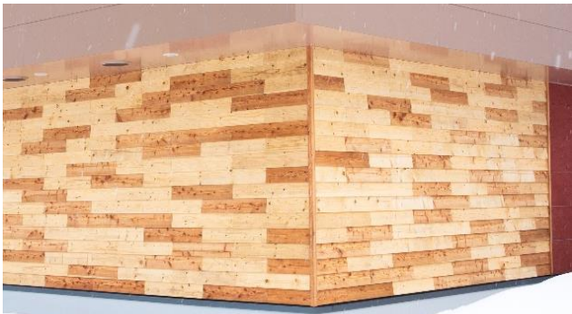
外壁（トドマツ・カマツ・エゾマツの下見板張り）
