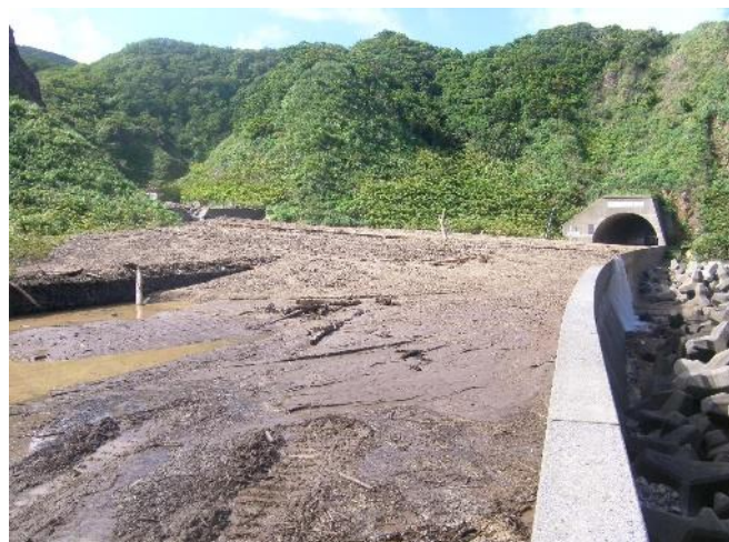
流出した土砂で覆われた道道。この災害により稲穂地区・湯浜地区・奥尻地区で合計16箇所の被害が確認されました。
