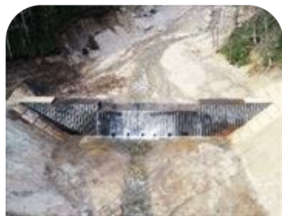
軽量鋼矢板床固工
