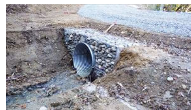
新設工事の 排水施設
