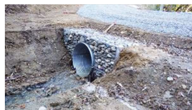
新設工事の 排水施設
