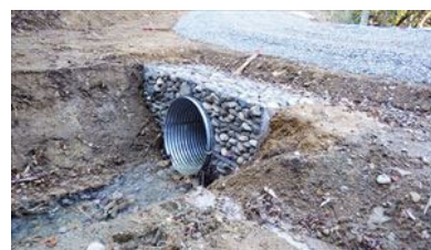
新設工事の 排水施設
