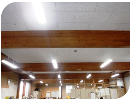
庁舎内のトドマツ構造用大断面集成梁
