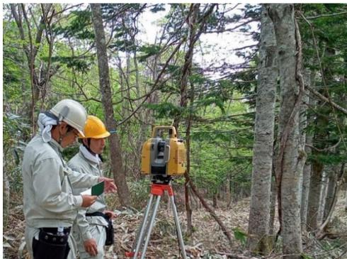
レーザーキャナーによる3D測量の様子
