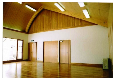
大断面集成材を使用した会議室
