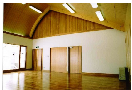
大断面集成材を使用した会議室
