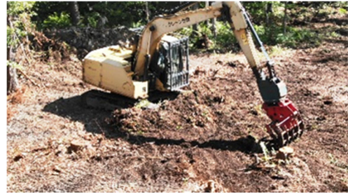
大型機械を用いてササの根を切断
