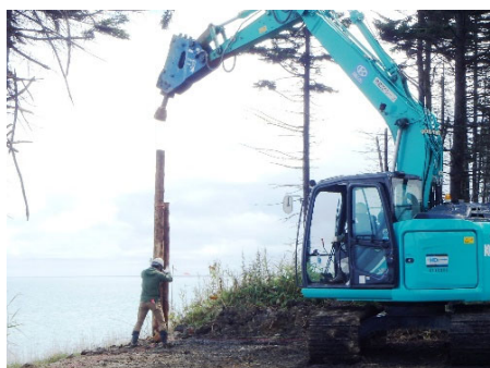
防風柵の作設
