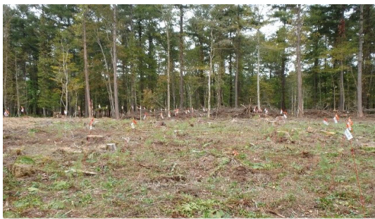
下刈実証地造成後（近景）(R3.11月撮影)
