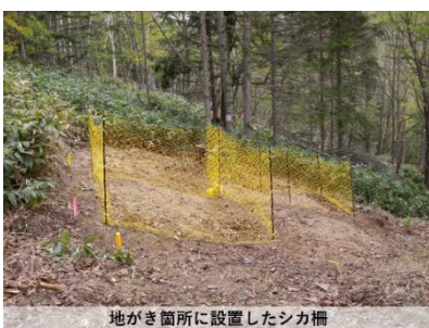
地がき箇所に設置したシカ柵
