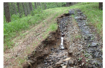
雨で深く洗掘されてしまった林道の様子
