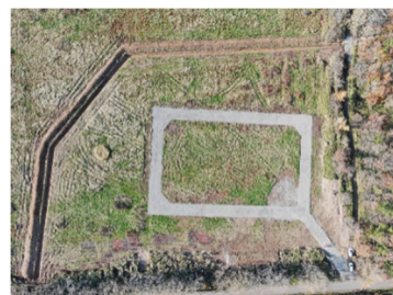
上空から見たストックヤード
