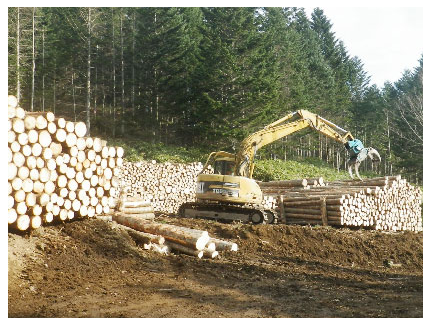
生産請負現場(土場)
